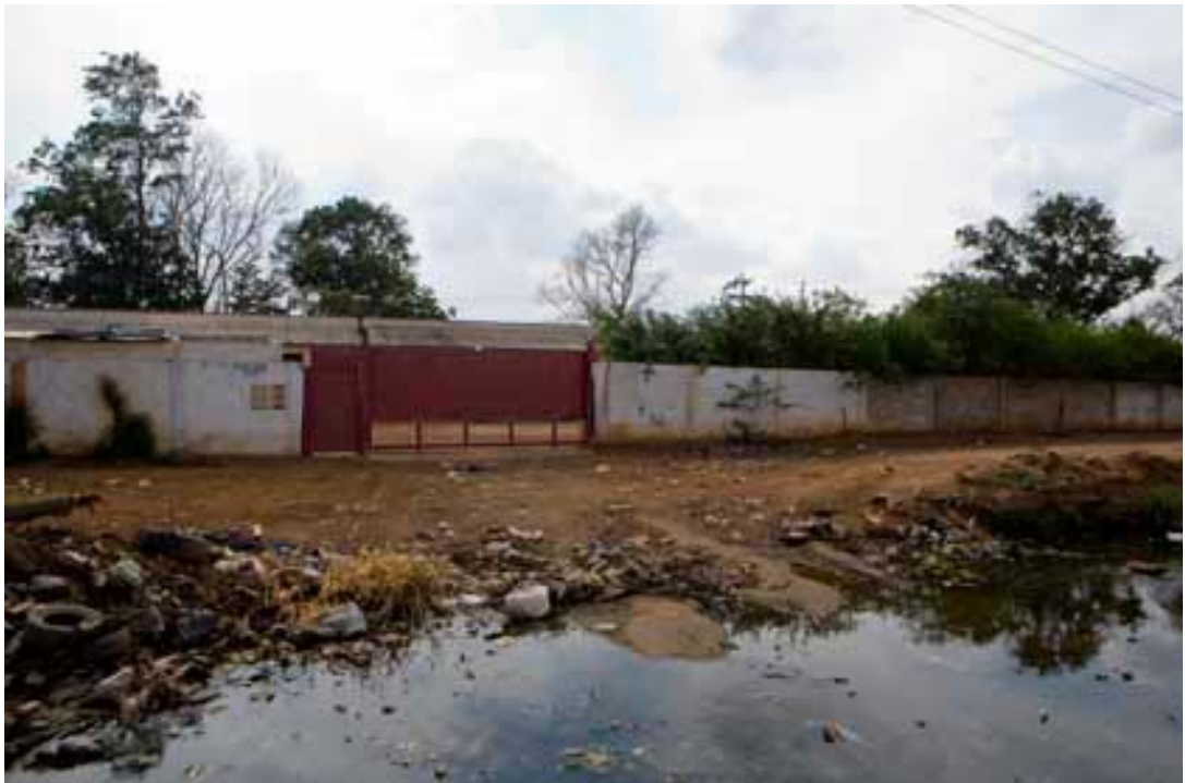
En esta fotografía incluida en un reportaje del diario La Verdad publicado el 20 de septiembre de 2015 puede apreciarse aun el portón metálico que resguardaba la obra. Ese elemento ya no estaba presente el día de la primera inspección de OVP-CODHEZ-Transparencia.
