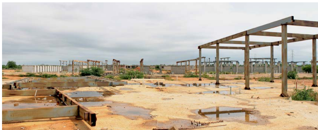
Panorámica de estructuras cortadas y desvalijadas de Control de acceso y Custodia interna (23-08-2016).
