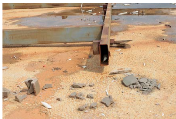
Detalle de corte de estructuras metálicas (23-08-2016).
