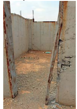
Módulo de Reclusión femenina, sin techos ni marcos metálicos en las puertas de celdas.
