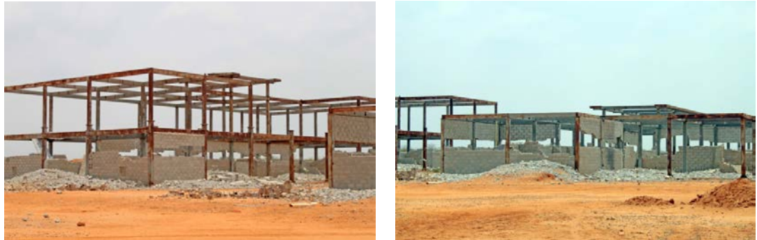
A la izquierda, el edificio de la Custodia externa. A la derecha, el economato.
