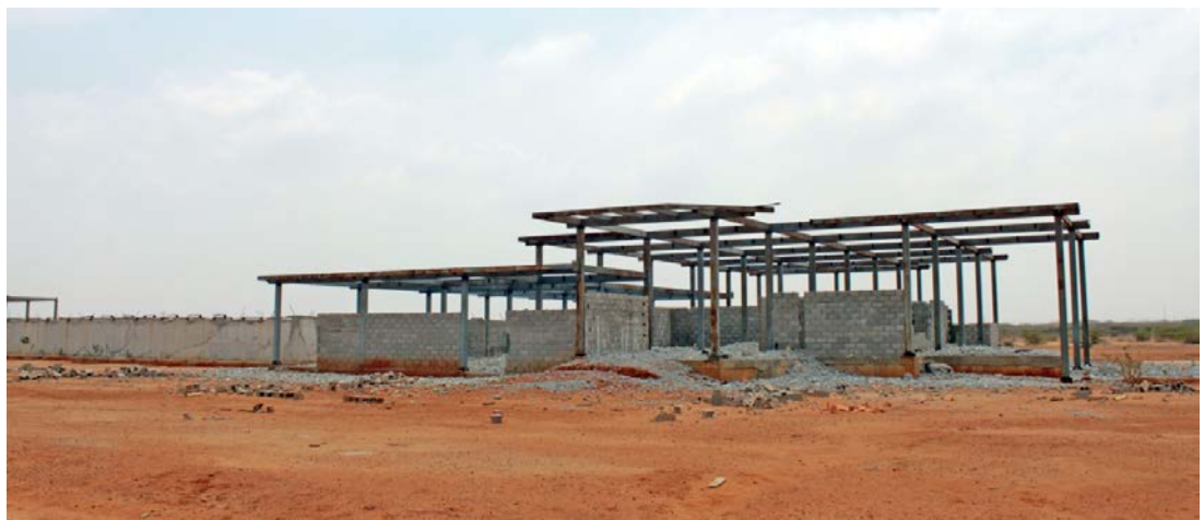
Cocina y Lavandería. A su derecha se ve una parte del edificio de Observación.
