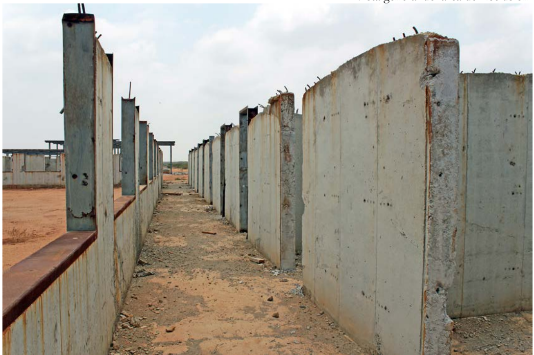
Módulo de Reclusión femenina, sin techos ni marcos metálicos en las puertas de celdas.
