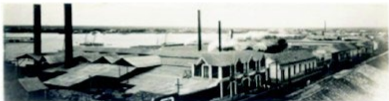
Planta generadora de la Maracaibo Electric Light Co.
