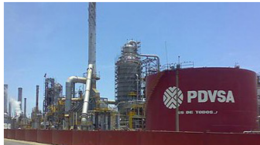
Refinería El Palito
